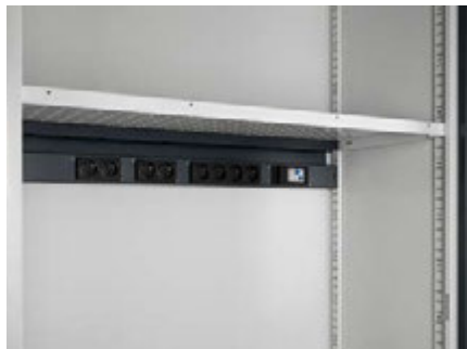
Applicazione canaletta elettrica sulla parte inferiore del piano-pannello forato
